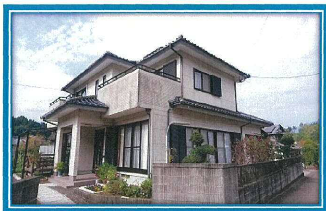
工事例・着工前
