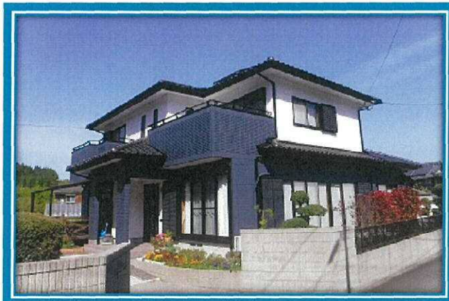
工事例・完成
